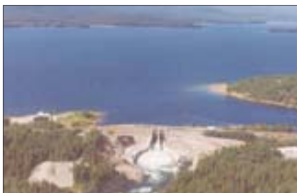
▲ Skins Lake Spillway
