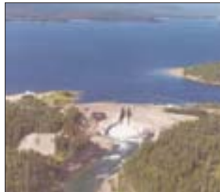
▲ Skins Lake Spillway
