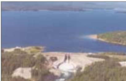
▲ Skins Lake Spillway
