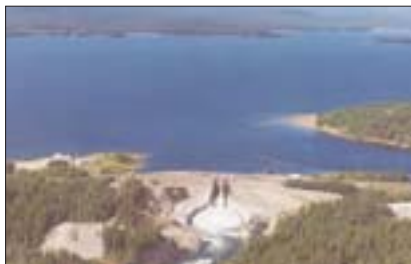
▲ Skins Lake Spillway
